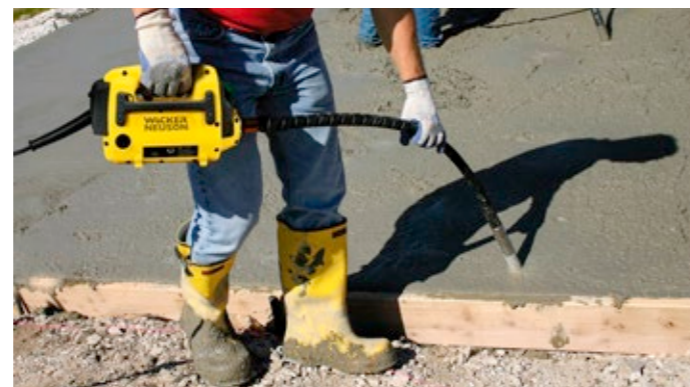
Wirtschaftliche Lösung: mit einem modularen System zum optimal verdichteten Beton mit der Basic-Linie HMS.
